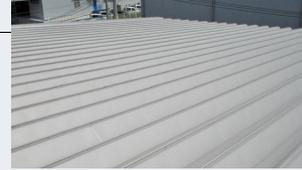
表面に結晶模様が見えます。新設の場合には表面の脱脂と目粗しが必要です。
