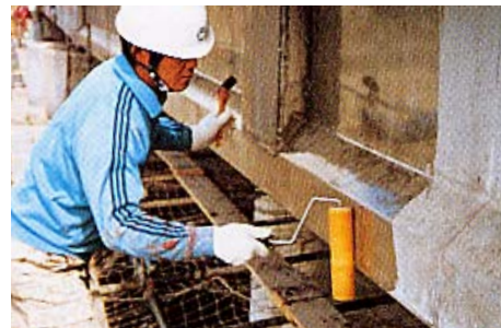
▲橋桁板施工中
