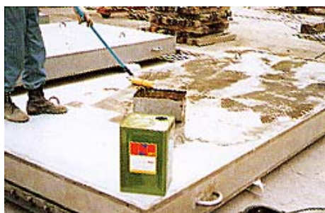
▲PC板施工中
