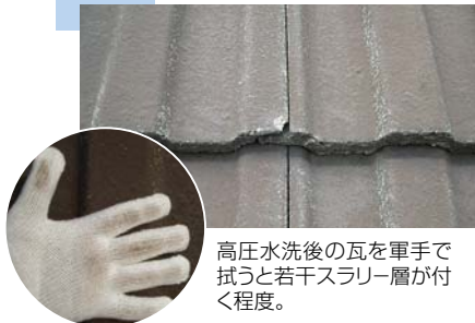
高圧水洗後の状態
