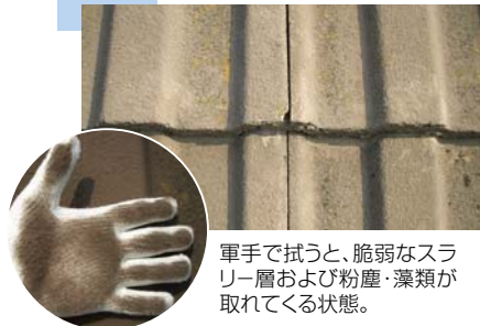
スラリー瓦洗浄前の状態
