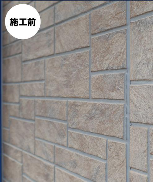
築10年の外壁。紫外線や雨水、粉塵などの汚れにより塗膜層にダメージ。光沢がなくなり、汚れも目立ち美観が悪くなります。
