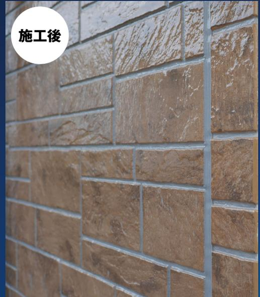
「シルビアUVカットフッ素クリヤー」で塗装後の外壁。光沢を復元し、紫外線をカット。低汚染性と高耐久性で、美観を長持ちさせます。
