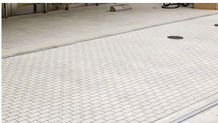
※写真は型枠式カラーグリッ 工法(KC-G工法)です。
