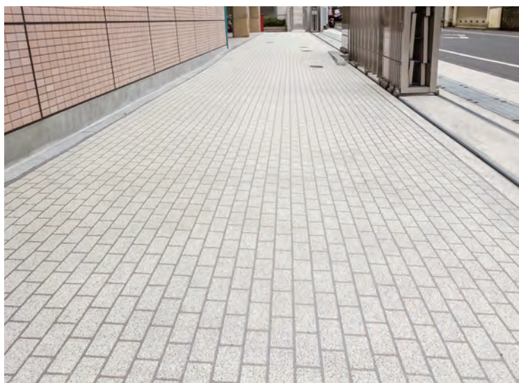
※写真は型枠式カラーグリップ工法(KC-G工法)です。
