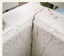
コンクリートのひび割れ例
