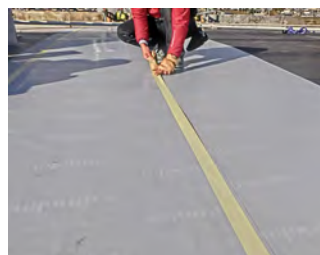
▲ジョイントテープの施工
