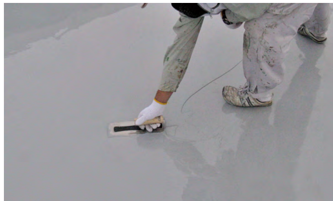
防水材の施工(2層目)
