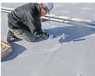
▲メカニカルアンカーの打ち込み
