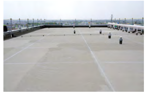
下地処理完了
