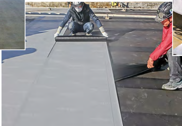
通気緩衝シート(ブルーフロンNT-FタックシートS)の施工
