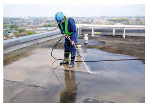
著しい汚れは漏水に配慮し、高圧水洗浄などで除去してください。
