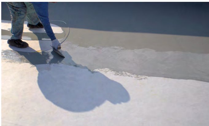
防水材の施工(1層目)
