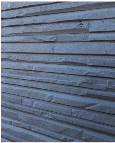
施工前の状態
