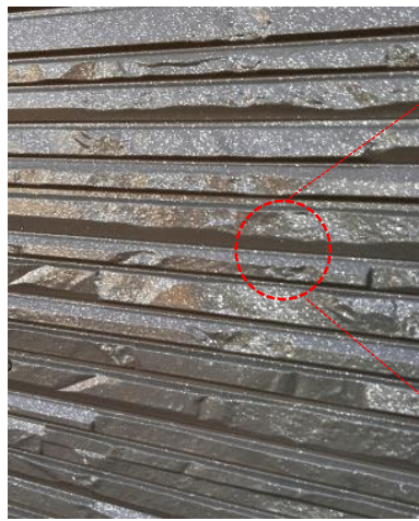
施工後の状態
